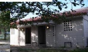
シャワー・トイレ棟
